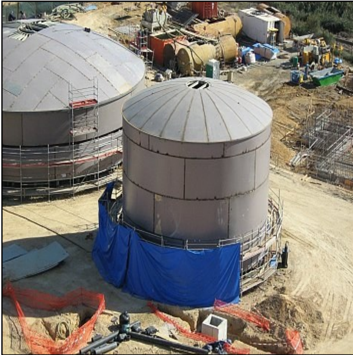
Baustellenansicht Figueira da Foz (Portugal) – Baustellenmontage von Lagertanks
