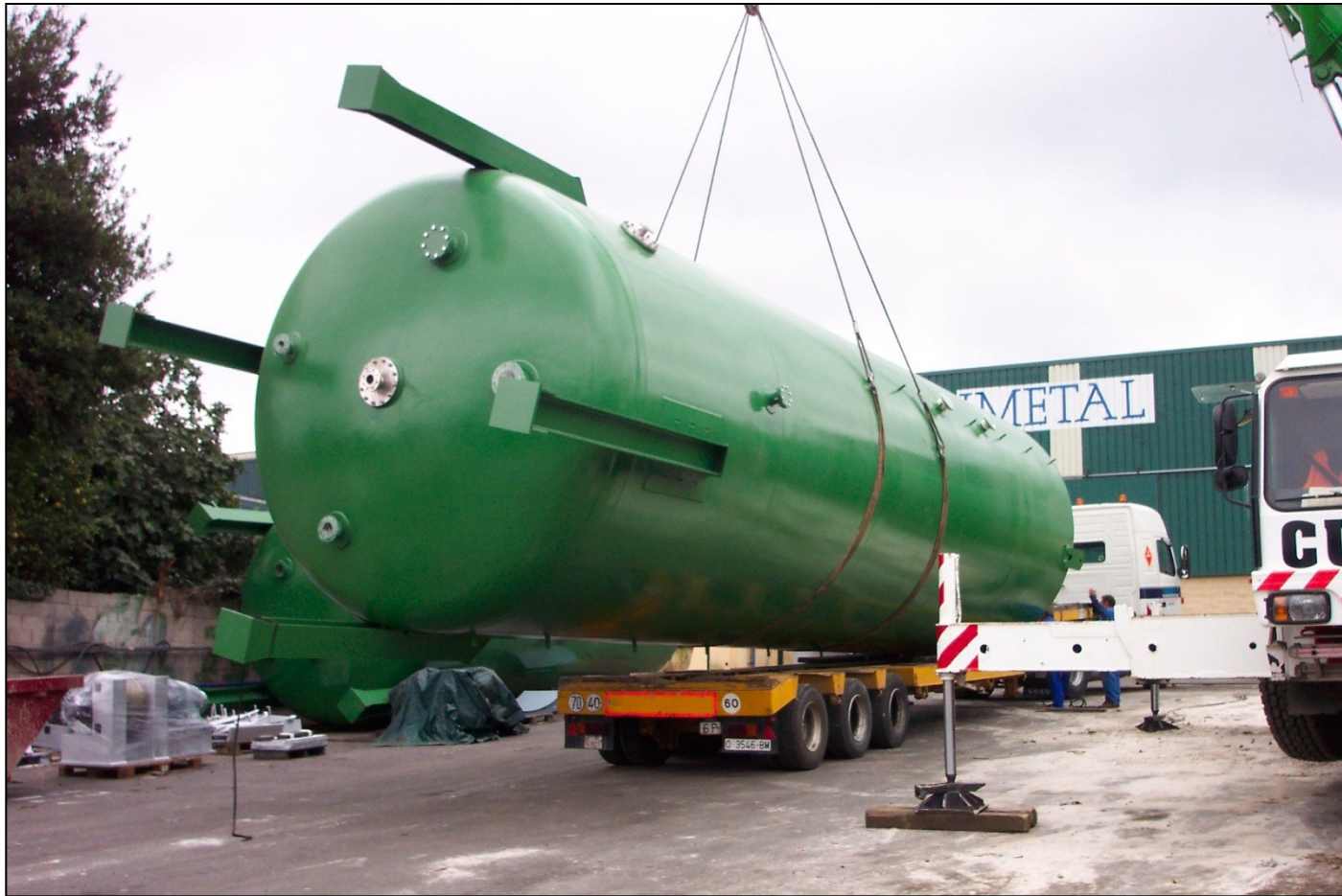
Nitrier- + Denitriertanks – Beladung mit Mobilkran.
